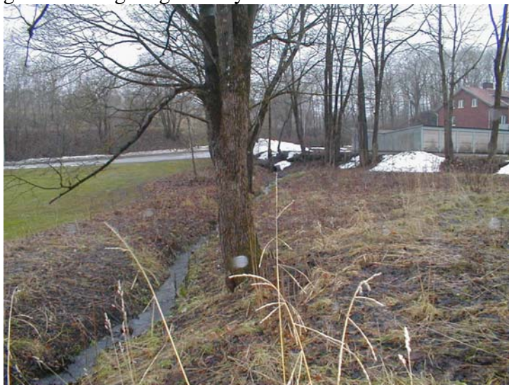
Bild 11. Befintligt dike mot väster
