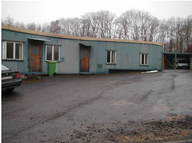
Bild 4. Vadden västra byggnaden
